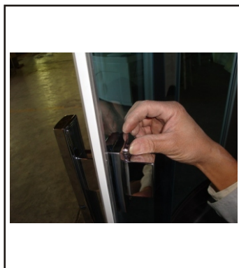
25. Monter magnetstripe på glassdørene
