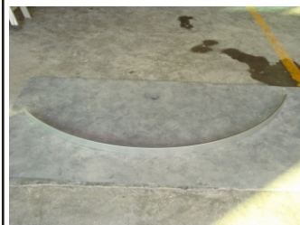
18. Installer aluminiumsrammen til glassdøren
