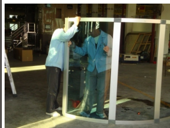
19. Installer glass på siden av glassdøren
