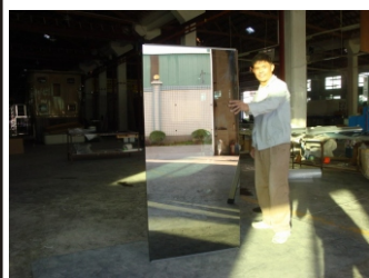
16. Installer glass på høyre side
