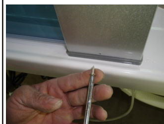
15. Fest alurammen med M6X25-bolter og muttere
