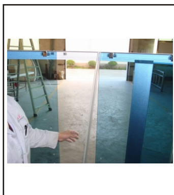
25. Monter magnetstripe på glassdørene
