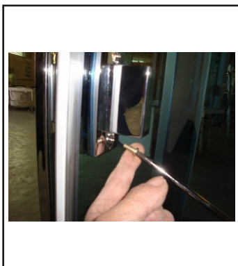
25. Monter magnetstripe på glassdørene
