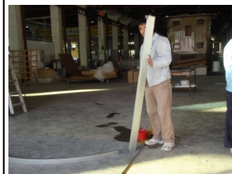
18. Installer aluminiumsrammen til glassdøren
