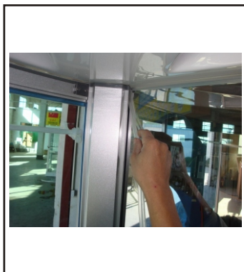
38. Klipp til den elastiske gummipakningen i riktig lengde, og press den mellom glass og aluminiumsramme fra topp til bunn i alle overganger mellom glass og alu.
