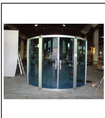
28. Glassdøren er ferdig
