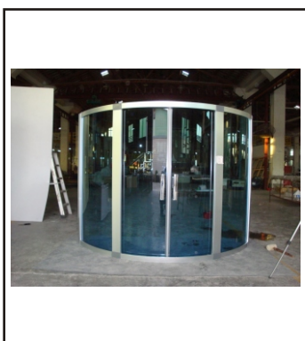
28. Glassdøren er ferdig
