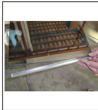
4. Innstaller den H-formede listen til alle glasstykker
