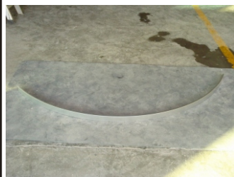
18. Installer aluminiumsrammen til glassdøren
