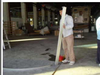
18. Installer aluminiumsrammen til glassdøren
