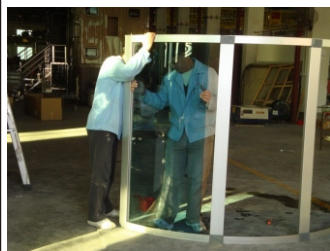
19. Installer glass på siden av glassdøren
