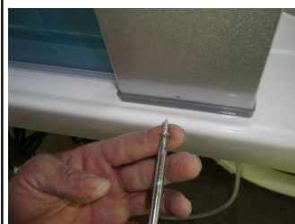
15. Fest alurammen med M6X25-bolter og muttere
