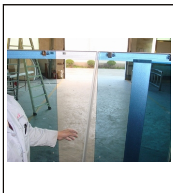
25. Monter magnetstripe på glassdørene
