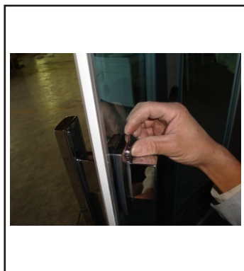
25. Monter magnetstripe på glassdørene
